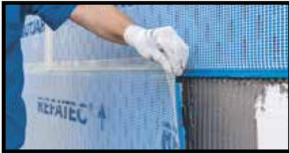
Einpassen der Isoliermatten CeraVent von oben nach unten, verschoben
