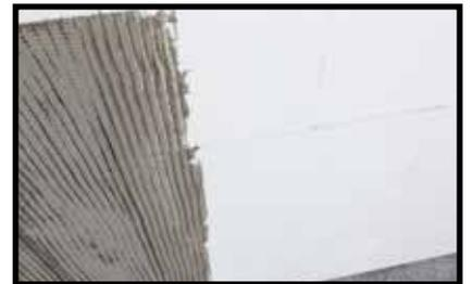
Auftragung der ersten Schicht PLANITOP HDM MAXI
