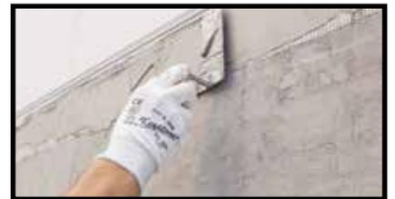
Positionierung des Profils mit Versenkung des Netzes
