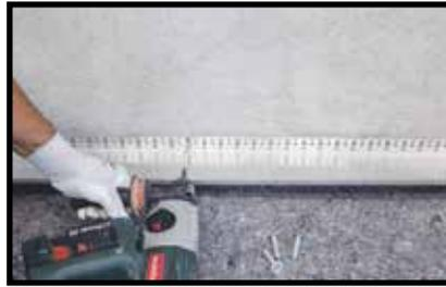
Positionierung der Startprofile MAPETHERM BA
