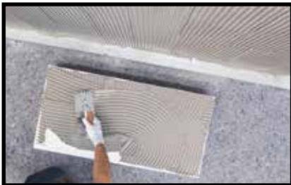
Verlegung der Isolierplatten mit doppelter Auftragung (Plattenrückseite)
